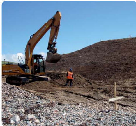
Ehen Spit Excavation
