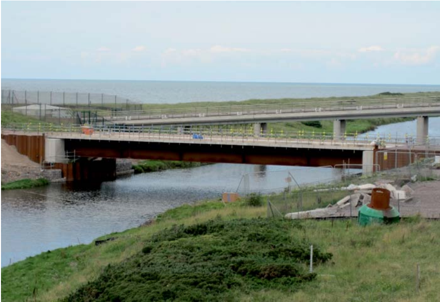
River Ehen Bridge
